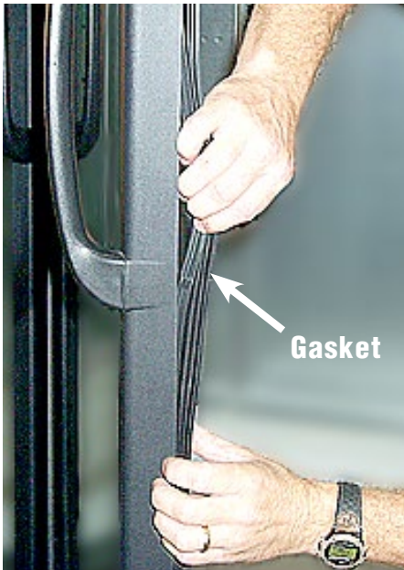
Remove Door Gasket
