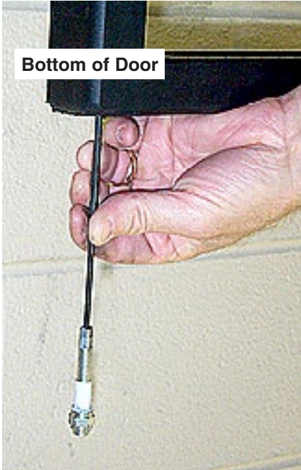
Replace Door Hinge Spring
