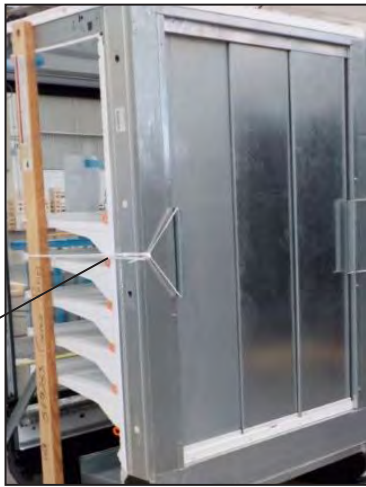
Remove tie cable
