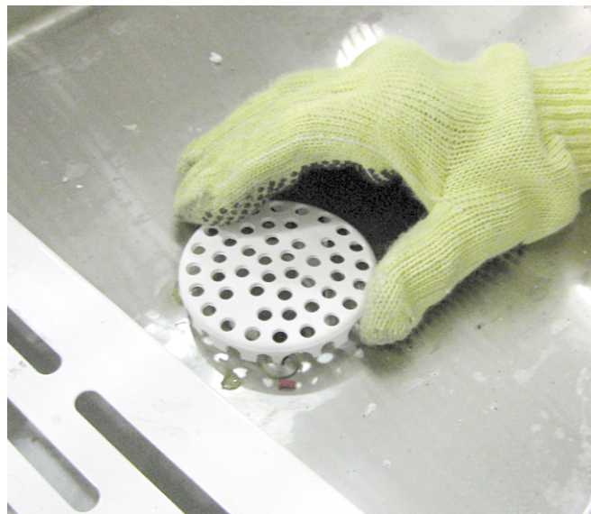
Salida de desagüe
