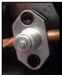
Robinet de dérivation de conduite de réfrigération
