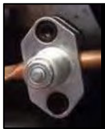
Robinet de dérivation de conduite de réfrigération
