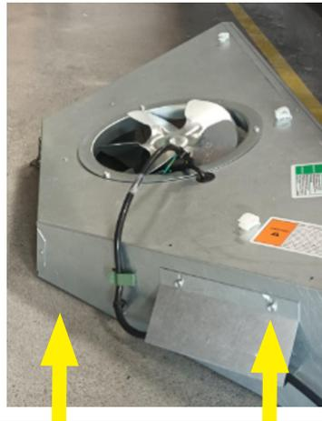
Levante el pleno del ventilador. Use la cadena para enganchar el pleno del ventilador y facilitar la limpieza.
